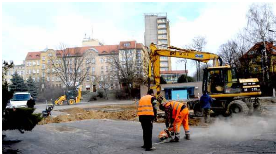
Ruszyły prace związane z budową parkingu na byłej pętli autobusowej
