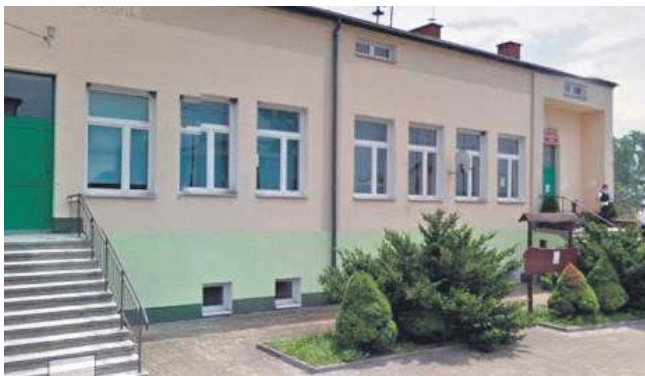
Budynek GOK-u w Łaszczowie zostanie przebudowany.
