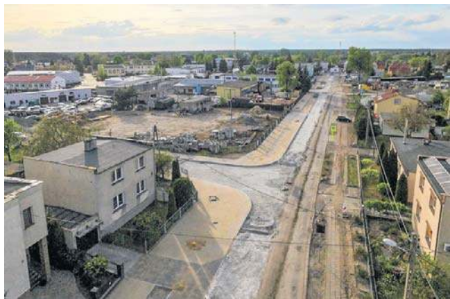
Po zimowej przerwie prace na ul. Grunwaldzkiej przyspieszyły.
