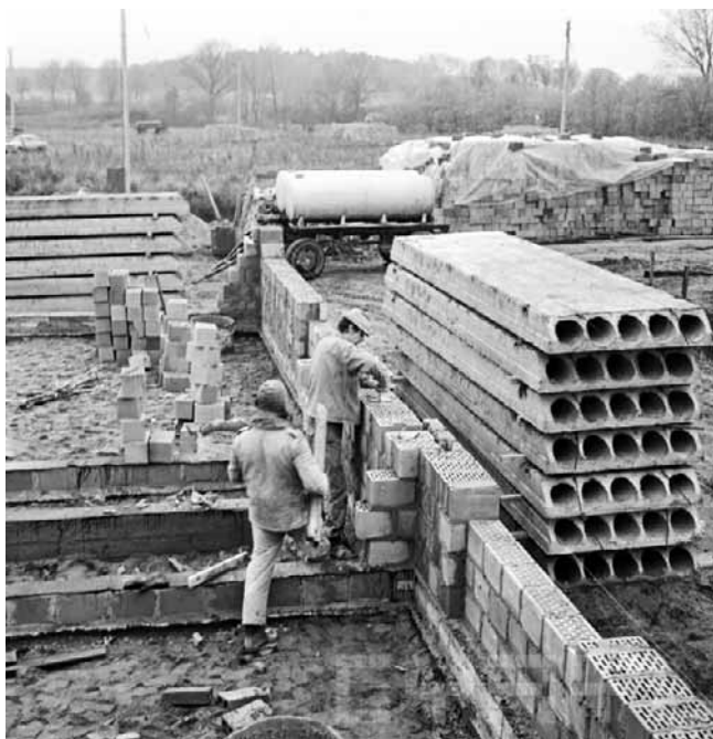
Budowa domów jednorodzinnych na Strzeszynie, które dały początek osiedlu - 1973 rok
