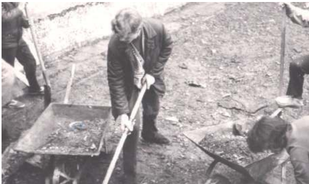
Prace przy budowie boiska
