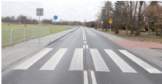
Wyremontowana droga Łucka-Kaznów (fot. Starostwo Powiatowe)
