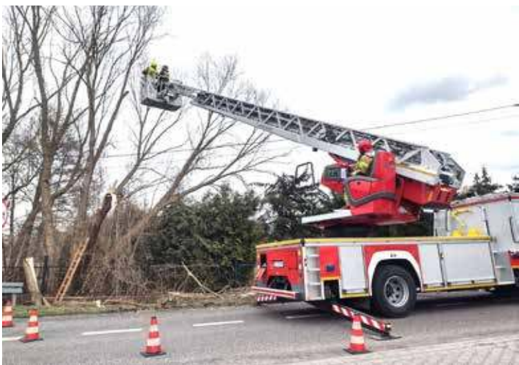
W miejscowości Wiechowo strażacy usuwali połamane drzewo, które niebezpiecznie zwiisało nad liniami energetycznymi. Foto. OSP. Marianowo
