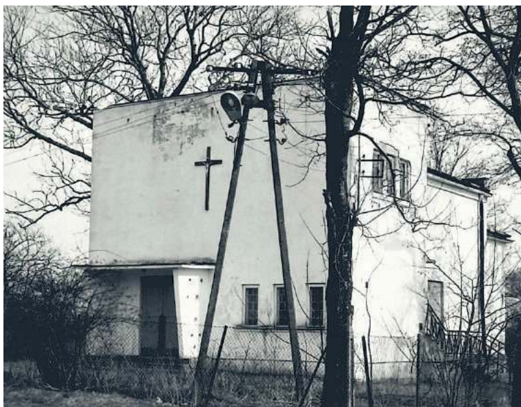
Białopole, kaplica dworska po przebudowie w okresie powojennym, na przełomie lat 80. i 90. XX w. filialny kościół rzymskokatolicki pw. MB Częstochowskiej parafii w Buśnie, fot. Bronisław Seniuk, 1998 r.
