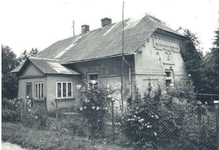
Białopole, dawna kuźnia i stolarnia dworska z 1892 r., obecnie budynek mieszkalny, fot. Mieczysław Kseniak, 1990 r.
