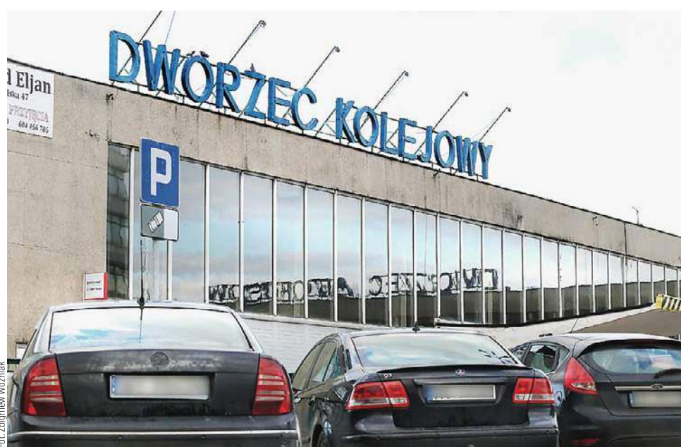
Budowa nowego dworca zakończy się prawdopodobnie w połowie 2023 roku
