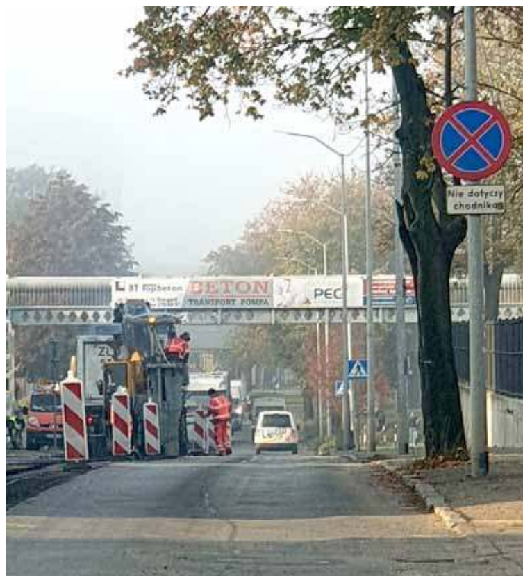
We środę firma Strabag rozpoczęła przebudowę ulicy na odcinku skrzyżowania z ulicą Ceglana. Stoj!Stargard
