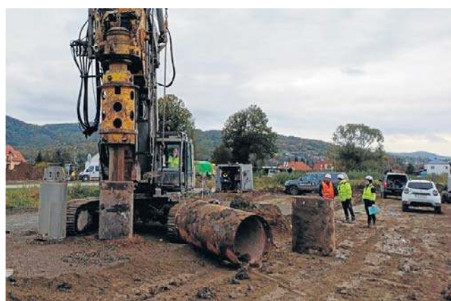
Prace przy montażu żelbetonowych pali na drodze ekspresowej S19
