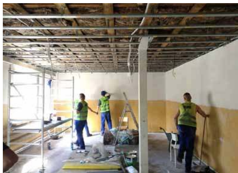
W ramach kursów szkoleniowych osadzeni zdobyli umiejętności w zawodzie technolog robót wykończeniowych w budownictwie
