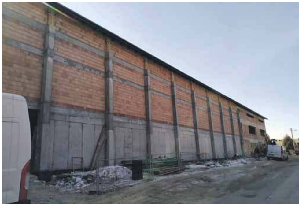
Hala sportowa powstaje przy szkole w Szaflarach.
