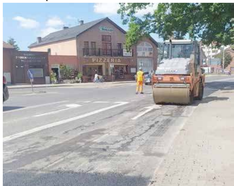
Prace prowadzone były tylko na najbardziej poniszczonych odcinkach jezdni
