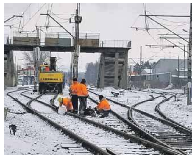
Mimo ubiegłotygodniowego śniegu pracownicy kolejowi ruszyli do remontu torowiska.
