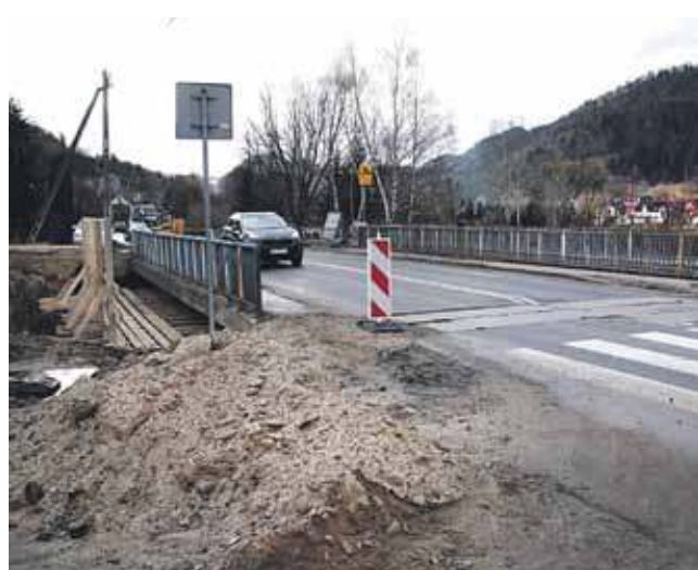
Trwa przebudowa mostu na Kozłeczyźnie w Krościenku.
