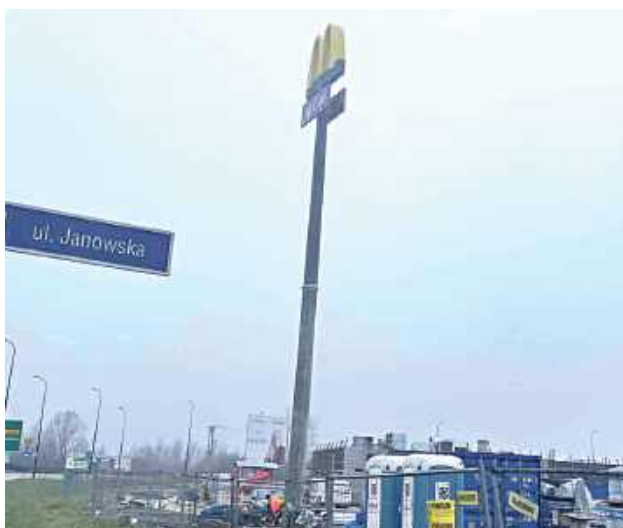
Na ziemi jeszcze plac budowy, ale nad miastem już unosi się majestatyczne „M”
