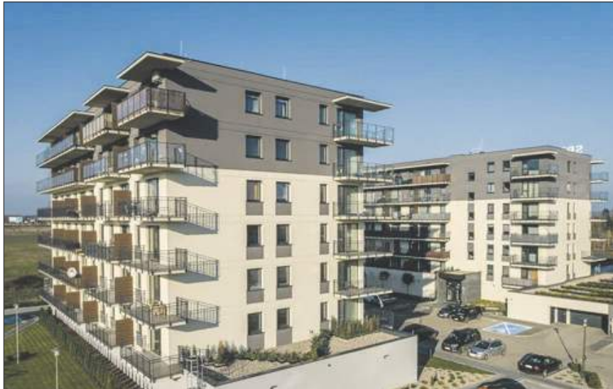
➦ Budowa budynku nr 8 na osiedlu Zamojskiego w Garwolinie (developer: Grupa Ochnik Inwest)
