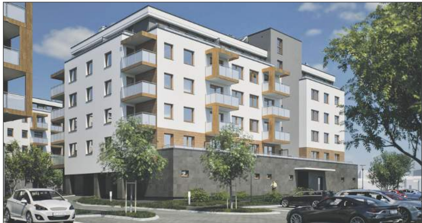
➦ Apartamenty nad Wilgą (II etap) - budowa zespołu dwóch budynków mieszkalnych wielorodzinnych z garażami na działkach przy ul. Targowej w Garwolinie (developer: Spółka Czan)
