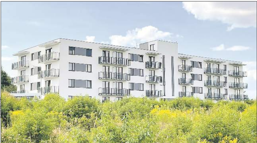
➦ Inwestycja przy ul. Jana Kochanowskiego w Rykach. Obiekt posiada 64 lokale na 4 kondygnacjach (developer: Spółka OPM3)
