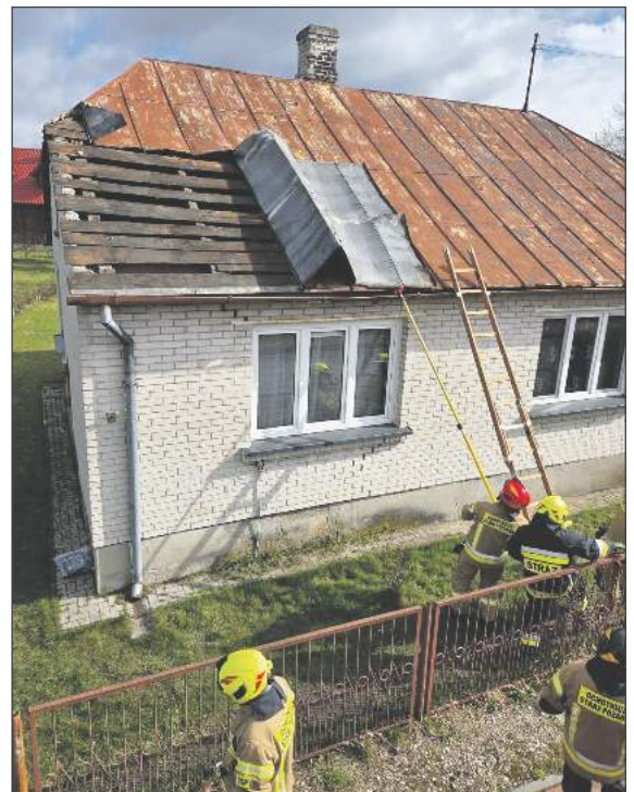
❖ Strażacy z PSP w Rykach oraz druhowie ze Stężycy w Lany Poniedziałek zostali zadysponowani do zerwanego dachu na jednym z domów w Stężycy (fot. OSP Stężyca)
