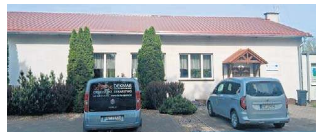
Dzięki przeprowadzonym pracom budynek świetlicy został lepiej zabezpieczony przed działaniem warunków atmosferycznych
