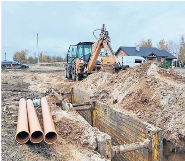
Uzupełnianie braków w kanalizacji wymaga sporych nakładów finansowych oraz czasu
