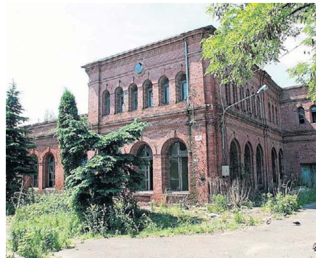
Tak do niedawna wyglądała zabudowa starej fabryki
