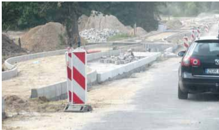
Krzywin - wygląda jak budowa autostrady, a czas leci
