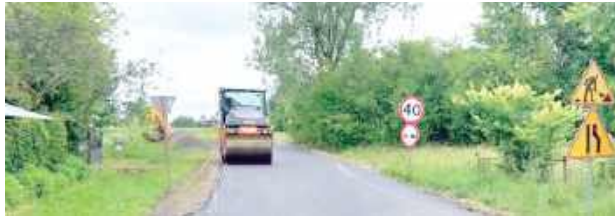
Inwestycja w Urszulinie obejmie przebudowę około 700-metrowego odcinka drogi. W ramach prac powstanie nowa nawierzchnia, przejście dla pieszych oraz chodnik na fragmencie trasy przebiegającym przez teren zabudowany
