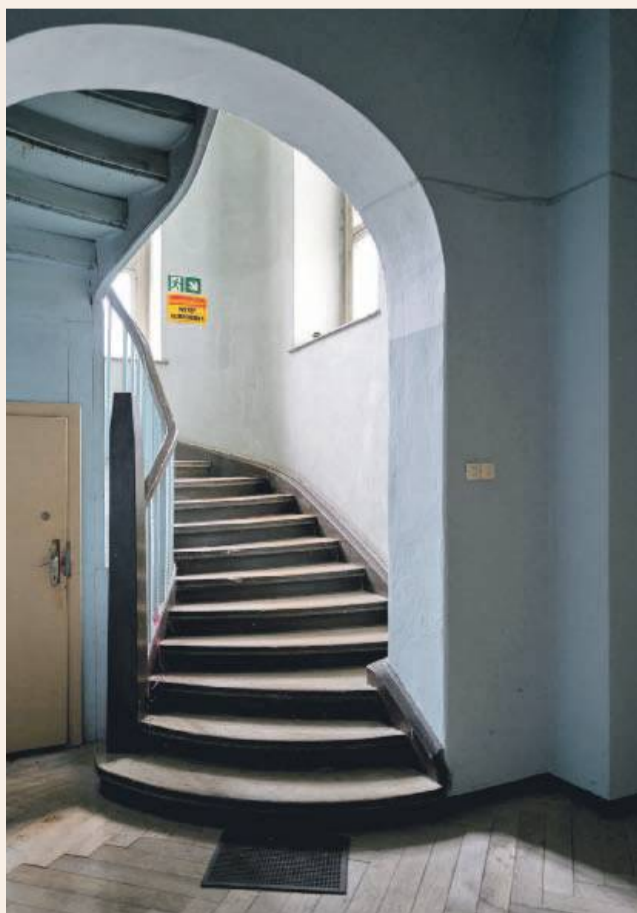
Klatka schodowa w pałacu - stan obecny
