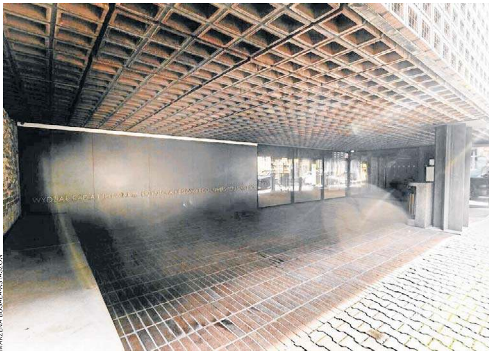
Elewacje zostały wykonane z setek ażurowych kształtek ceramicznych
