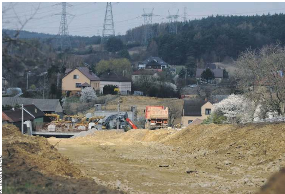
Budowana estakada w Byczynie
