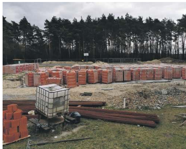
W tym miejscu powstaje sala gimnastyczna
