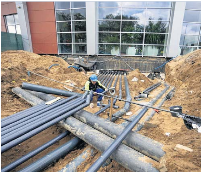
Trwają prace przy budowie zewnętrznego saunarium w Trzech Falach
