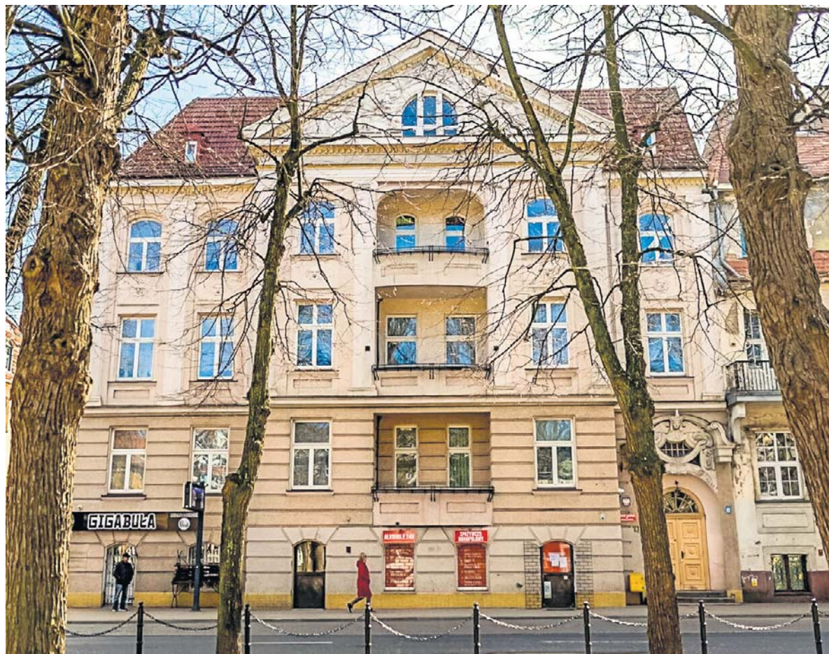
Kamienica przy al. Henryka Sienkiewicza. W tym budynku do 2020 roku mieścił się Urząd Morski w Słupsku. Od 1 sierpnia zacznie znowu działać
