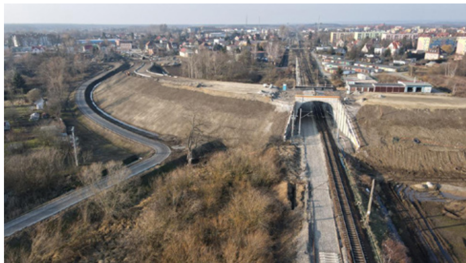
Luty 2025. Obejście w trakcie budowy.
