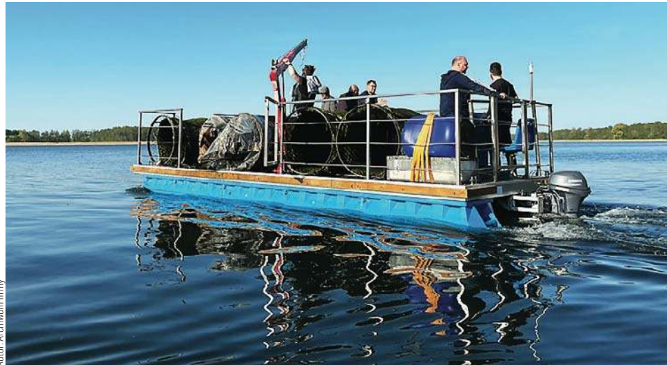
Montaż systemu oczyszczania wody na Jeziorze Skarlińskim koło Nowego Miasta Lubawskiego
