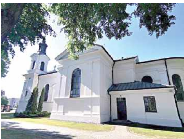
W kościele pw. św. Anny w Wohyniu przeprowadzono kompleksową renowację elewacji. Uzupełniono i odnowiono tynki zewnętrzne, pomalowano cały budynek, odtworzono elementy architektoniczne oraz naprawiono pokrycie dachowe, rynny i rury spustowe
