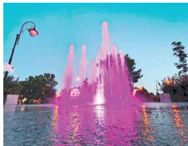
W ramach przedsięwzięcia na rynku powstała nowoczesna fontanna posadzkowa z podświetleniem LED. Zagospodarowano również przestrzeń wokół niej, montując stojaki na rowery oraz kosze na odpady. Celem inwestycji jest poprawa estetyki centrum miejscowości, zwiększenie jej atrakcyjności turystycznej oraz stworzenie przyjaznej przestrzeni do wypoczynku i integracji mieszkańców
