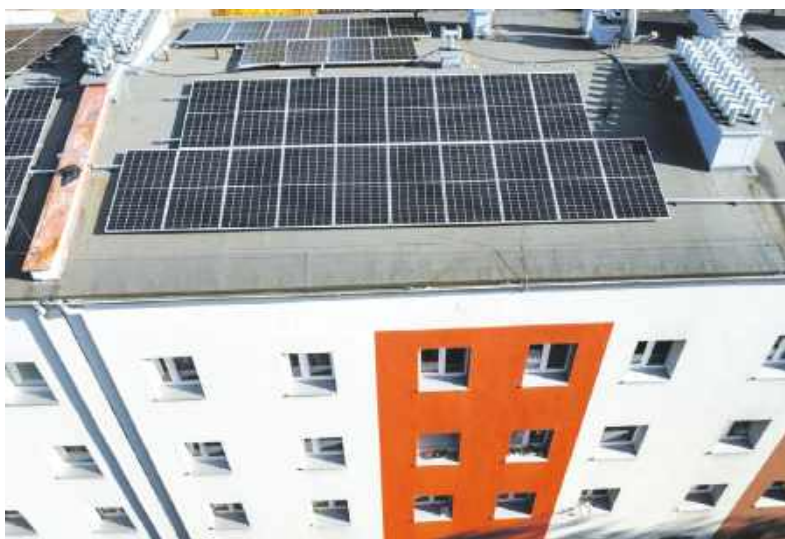
Kończą się prace polegające na montażu instalacji fotowoltaicznej na dachu budynku przy ul. Huty Julia 12 B w Bytomiu
