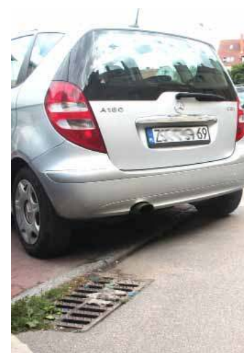
Widoczny na zdjęciu wpust studzienki deszczowej, jak zaznacza radny, jest zapchany
