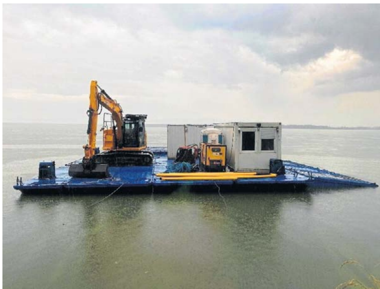
Będzie remont generalny zapory zbiornika wodnego Goczałkowice
