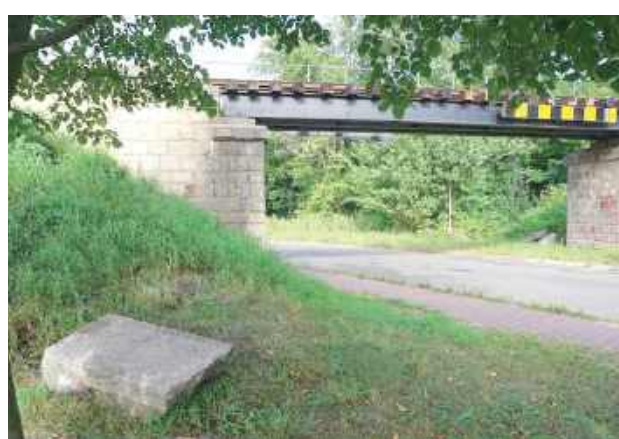
Remontu doczeka się też uszkodzony dwa lata temu wiadukt nad ulicą Rybacką w Opolu Lubelskim
