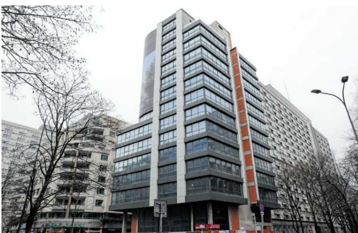
• Problem w Warszawie dotyczy centralnych dzielnic, szczególnie Śródmieścia. Na zdjęciu: budowa przy ul. Grzybowskiej 6a
