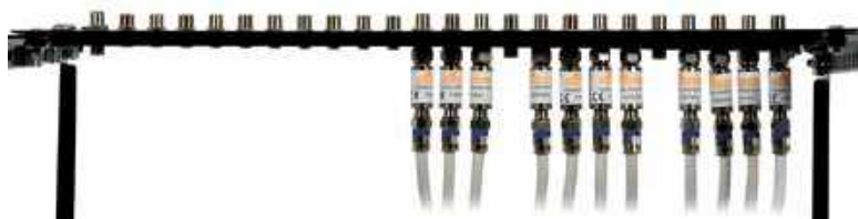
Zabezpieczenie przeciwprzepięciowe R48602 zainstalowane na patchpanelu R9120312 po wymianie przejścia F/F na dłuższe E80380
