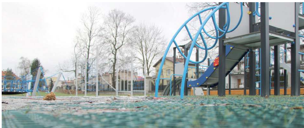
Plac zabaw pokryty jest matami przerostowymi. Pod taką nawierzchnią nie wykonuje się podbudowy z kruszywa. Kładzie się ją na gruncie rodzimym. Tylko taki sposób jest zalecany i dopuszczany przez producentów - twierdzi wykonawca placu. - Podbudowa była ujęta w projekcie będącym podstawą wykonywanych prac i stanowi część zakresu prac, które miał wykonać wykonawca - utrzymuje miasto
