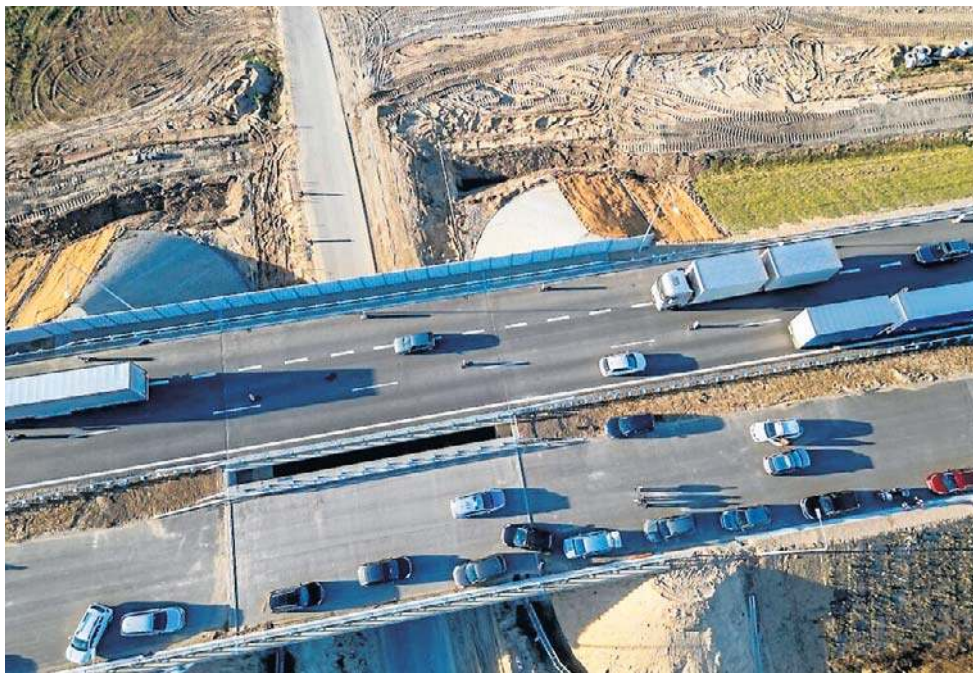
Od 2 października kierowcy mogą w pełni korzystać z obwodnicy Łomży. Tym samym zakończono budowę trasy Via Baltica w Polsce
