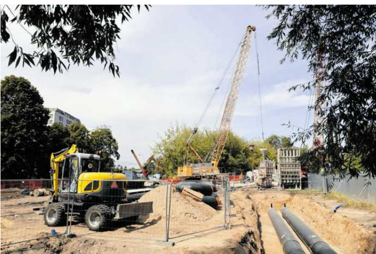
• Park Pięciu Sióstr. Prace związane z budową linii tramwajowej
