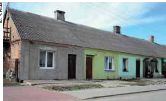
Jeden z popegeerowskich budynków w Zdunowie
