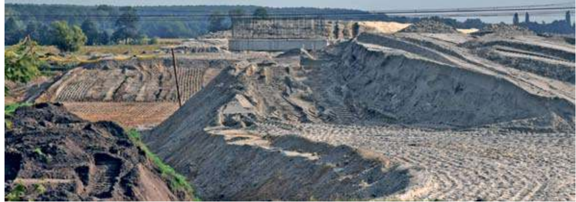
Obecnie już wyraźnie widać zarysy skarp nasypów nad wiaduktem kolejowym
