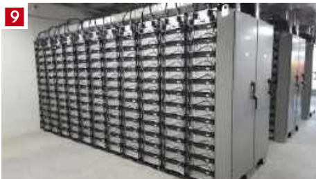
5. Opracowana przez NASA bateria z kołem zamachowym, 6. Stara pocztówka ukazująca kompleks hydroenergetyczny w Schaffhausen, 7. Ilustracja współczesnego systemu magazynowania energii z oze za pomocą kondensatorów, 8. Schemat japońskiego prototypowego SMES, 9. Magazyn energii oparty na akumulatorach litowo-jonowych, 10. Demonstracja systemu grawitacyjnego magazynowania energii firmy Gravitricity
