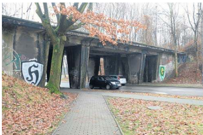
Wkrótce zniknie z krajobrazu Bogucic. Miejski Zarząd Ulic i Mostów w Katowicach przystąpi do rozbioru
