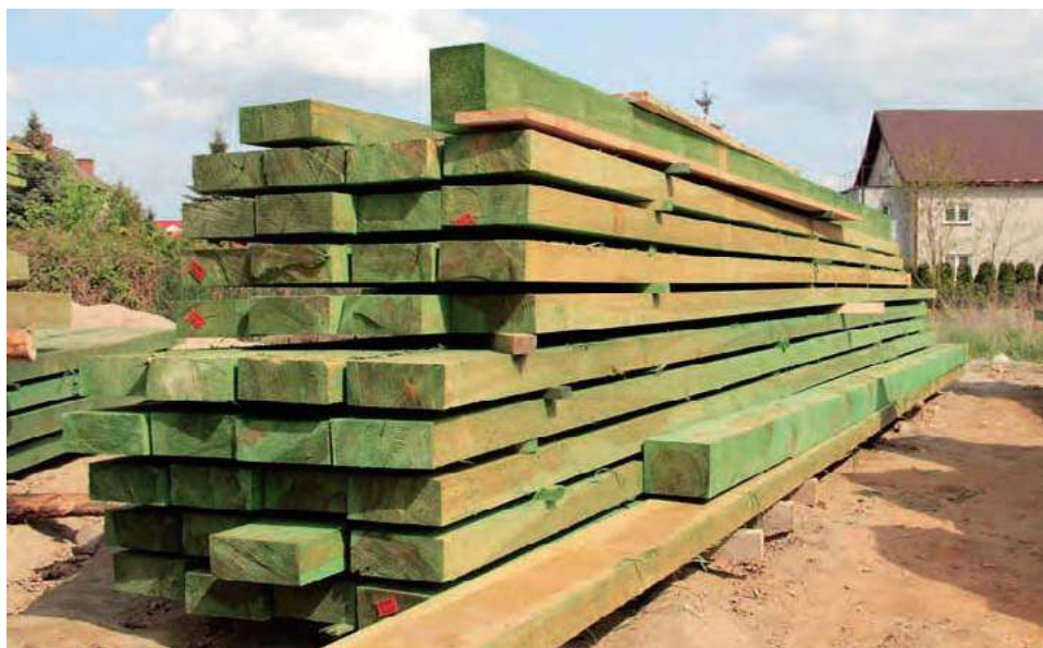
📍 Drewno na więźbę ma być okorowane, bez pleśni, sinizny, pęknięć, i co najważniejsze – zaimpregnowane. J. WERNER
