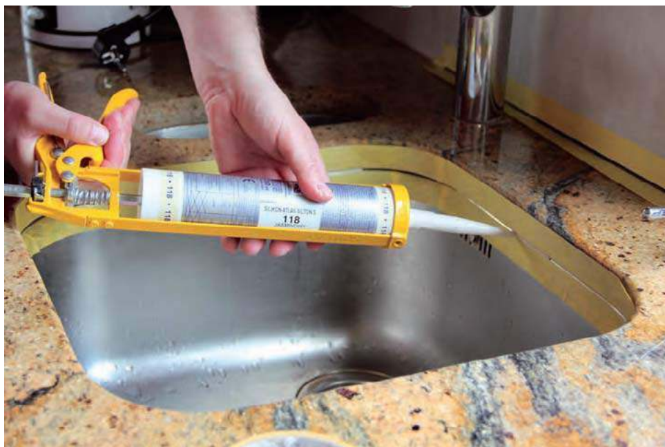
🔴 Silikon nakłada się równomiernym, ciągłym ruchem. A. WERNER
