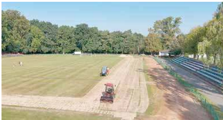
Prace na stadionie trwają od września 2024 roku. Niestety, nie pomogą środki ministerialne. Foto. UM Nowogard
