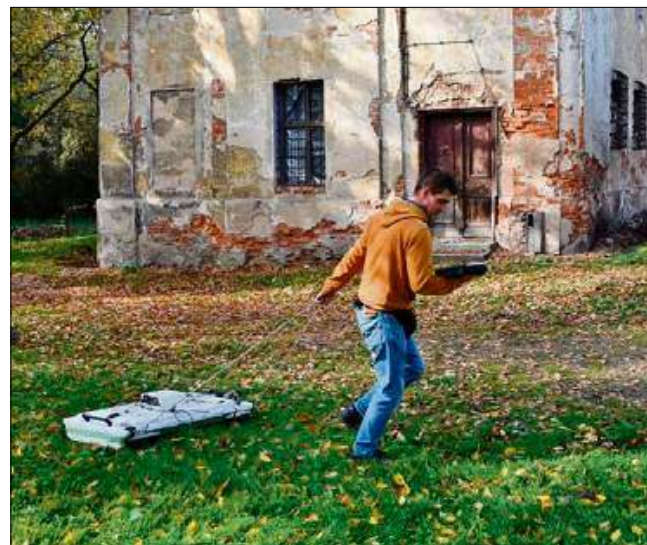
Na podstawie wyników możliwe będzie określenie miejsca, w którym znajdowały się wyburzone już fragmenty obiektu.
