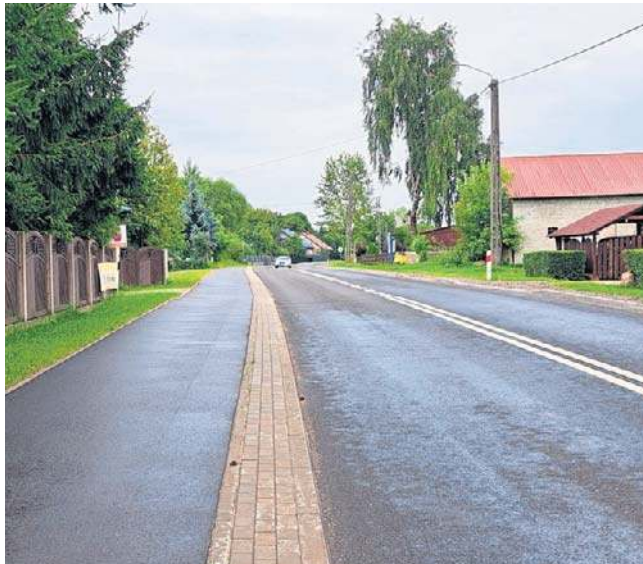
W tym roku udało się zakończyć budowę ścieżki rowerowej w Nowej Wsi łączącą Złotorię z Lubiczem Górnym
