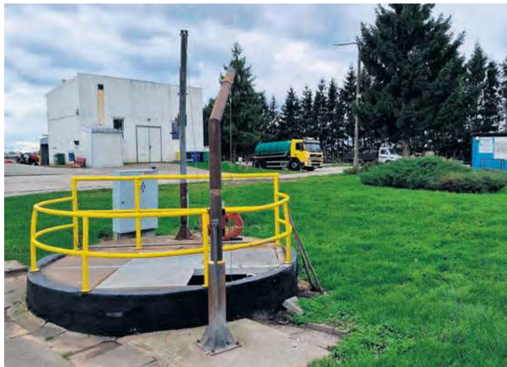
Firma MAREX Technology Sp. z o.o. z Drobina wykona dostawę i montaż wirówki dekantacyjnej z osprzętem na gminnej oczyszczalni.
