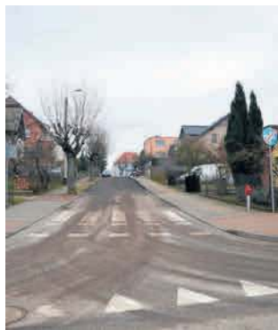
Prace zaczęły się między innymi na ulicy Cichej w Bytowie
