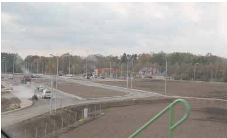
Miejsce Obsługi Podróżnych - zdjęcie wykonane jeszcze w trakcie budowy
