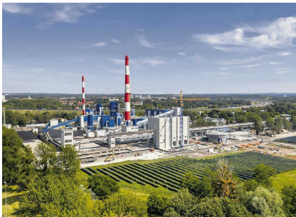
• Sercem kompleksu będzie blok energetyczny z parowym kotłem wielopaliwowym pracującym w wysokosprawnej kogeneracji, a więc produkującym jednocześnie ciepło i energię elektryczną. FOT. PARK ZIELONEJ ENERGII
