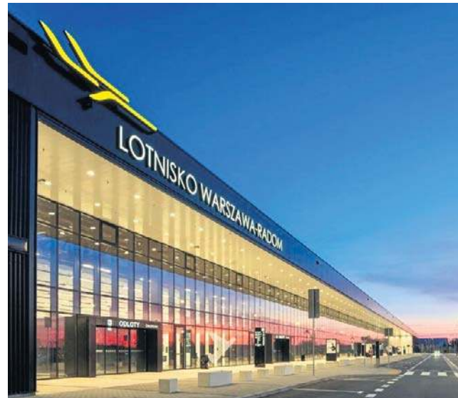
FOT. LOTNISKO WARSZAWA - RADOM
