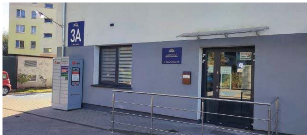
W ramach Spółdzielni Mieszkaniowej „Praca” w Iławie na terenie miasta działają cztery punkty obsługi mieszkańców. To pozwala skrócić czas reakcji na zgłoszenia i rozwiązywać problemy bezpośrednio w terenie. Na zdjęciu punkt dla osiedla Podleśnego przy ulicy Baczyńskiego 3A
