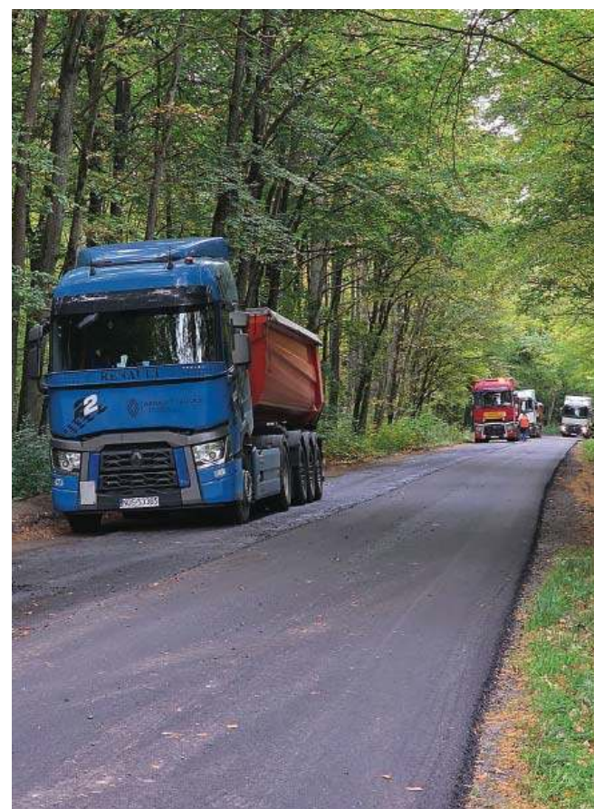
Ciężki sprzęt w akcji. Trwa asfaltowanie poszerzonej jezdni na drodze powiatowej od Iławy do Radomna
